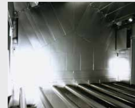
Manganverkleidete Wände und kurze Rollenabstände machen Materialtransporte ab einer Länge von 2500 mm möglich.
